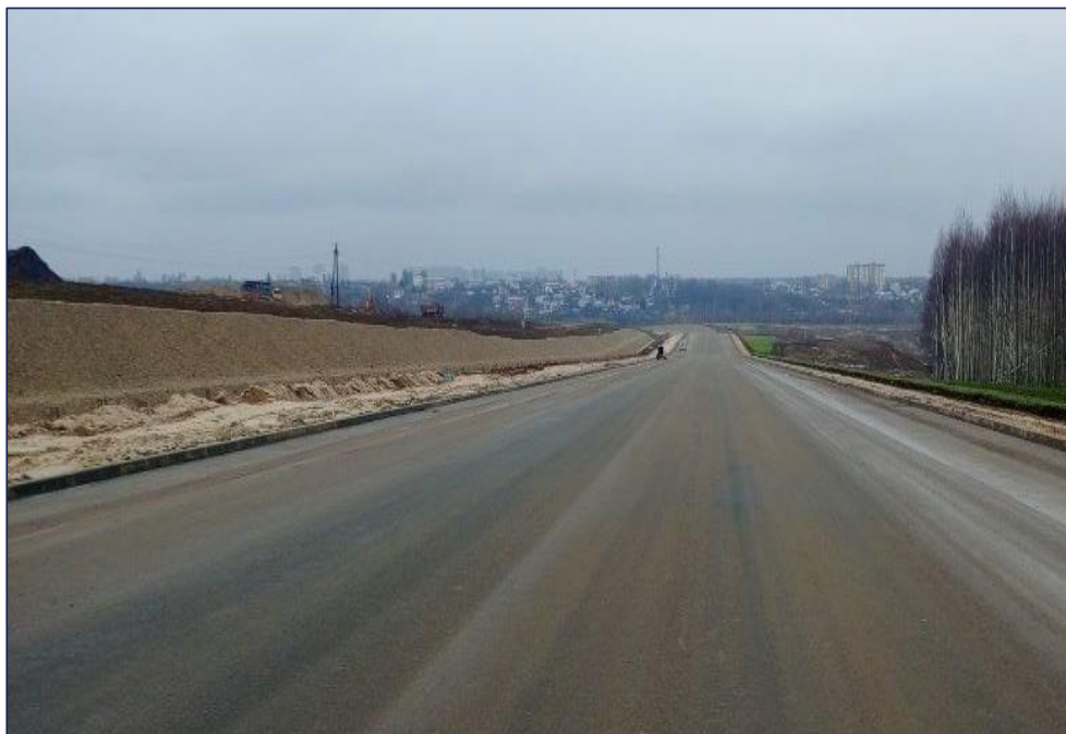
Строительство дублера проспекта Гагарина
